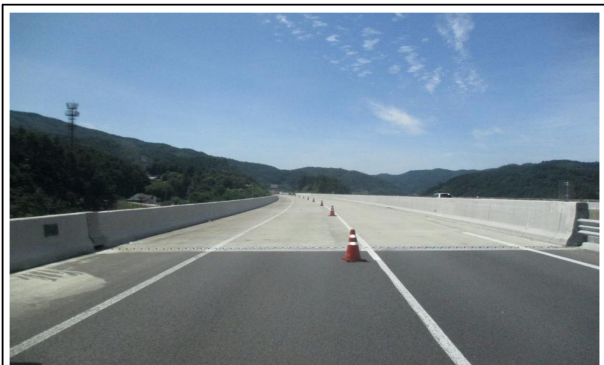
교량 상부 전경
